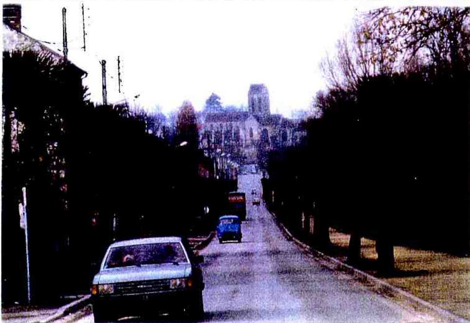
Vue depuis la D928. Sur tout le parcours depuis le centre de Méry sur Oise, L'église est le centre du paysage et prend de plus en plus d'importance au fur et à mesure de l'approche. Elle se présente là comme un véritable signal et constitue l'un des points forts du site d'Auvers.
